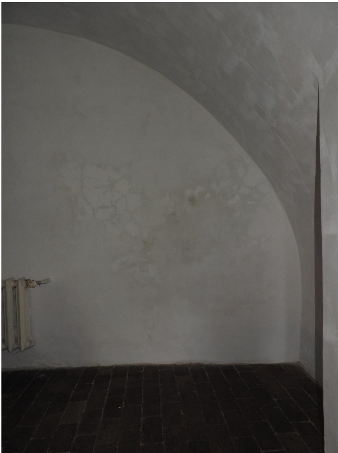
Fot. nr. 13 Stan tynków na ścianie południowej krypty zachodniej Zespół pomieszczeń kaplicy św. Michała. Zamek Pieskowa Skała, 1 piętro
